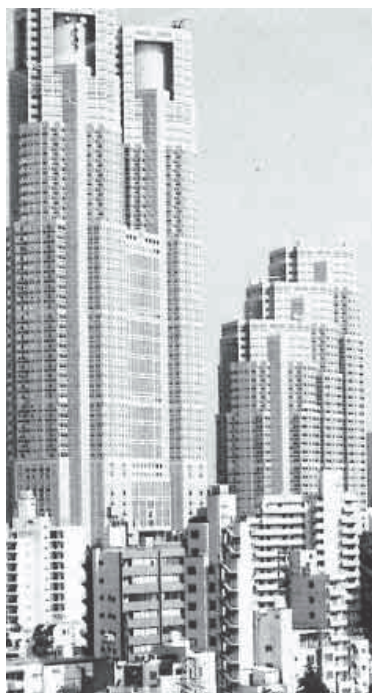
Stahlrahmen für Hochhäuser
